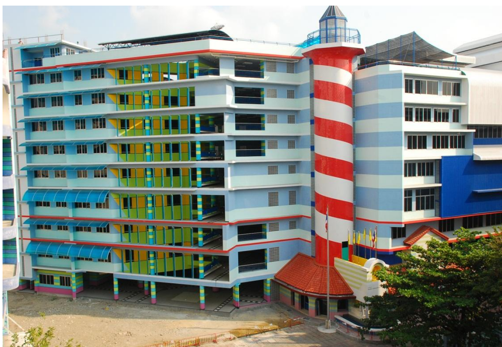
ภาพการดำเนินการก่อสร้างอาคารต้นแบบฉันทศึกษา
